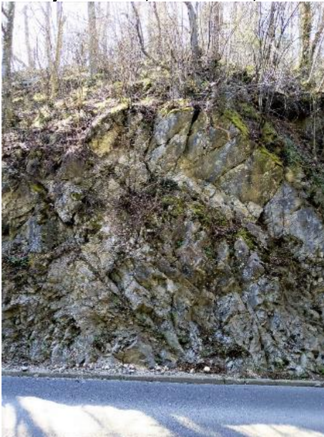
Lokacija 5 od km 8,856 do km 8,922
