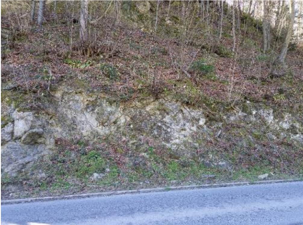
Lokacija 6 od km 9,28 do km 9,333
