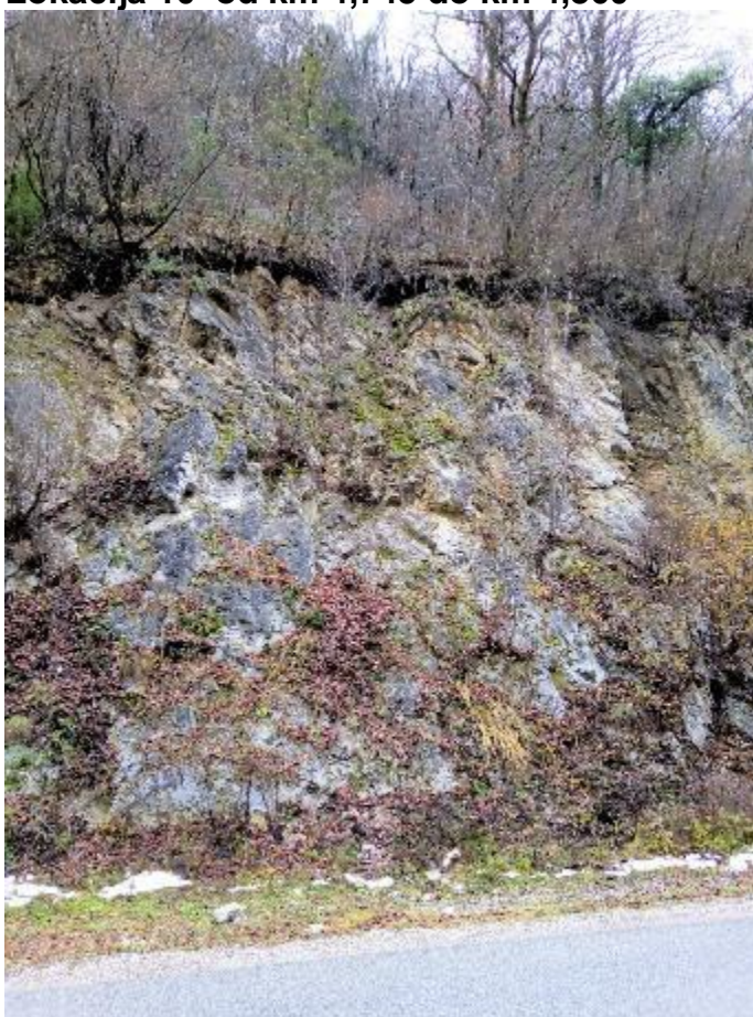
Lokacija 10 od km 4,745 do km 4,860
