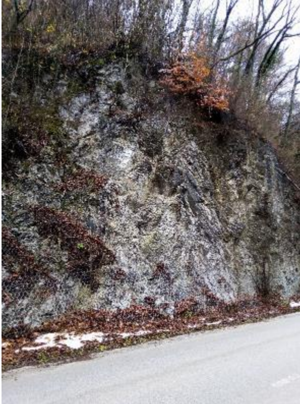
Lokacija 5 od km 3,269 do km 3,360
