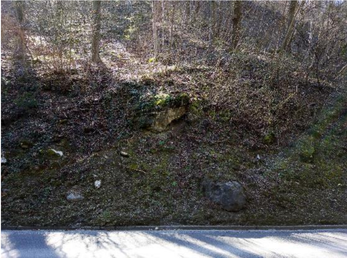
Lokacija 4 od km 8,806 do km 8,827
