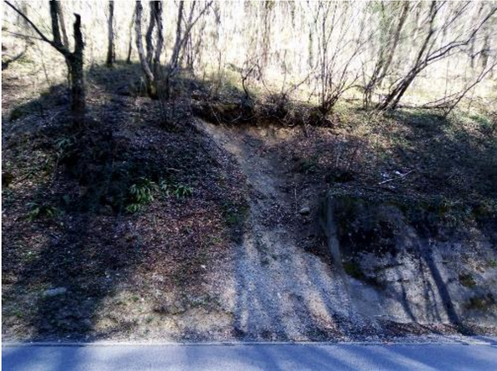
Lokacija 2 od km 8,69 do km 8,697
