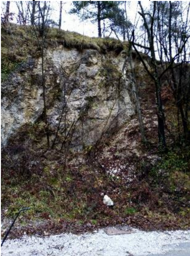
Lokacija 2 od km 2,337 do km 2,413
