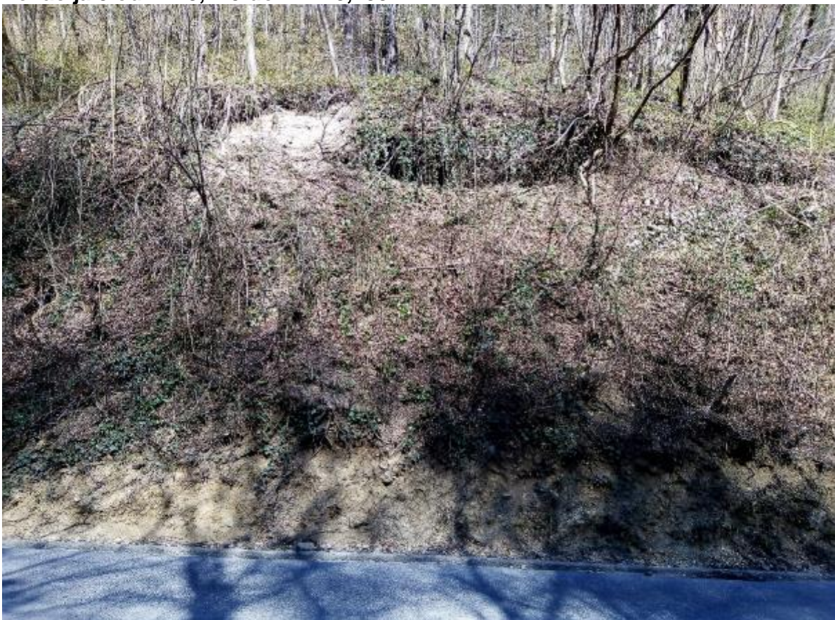
Lokacija 3 od km 8,725 do km 8,759
