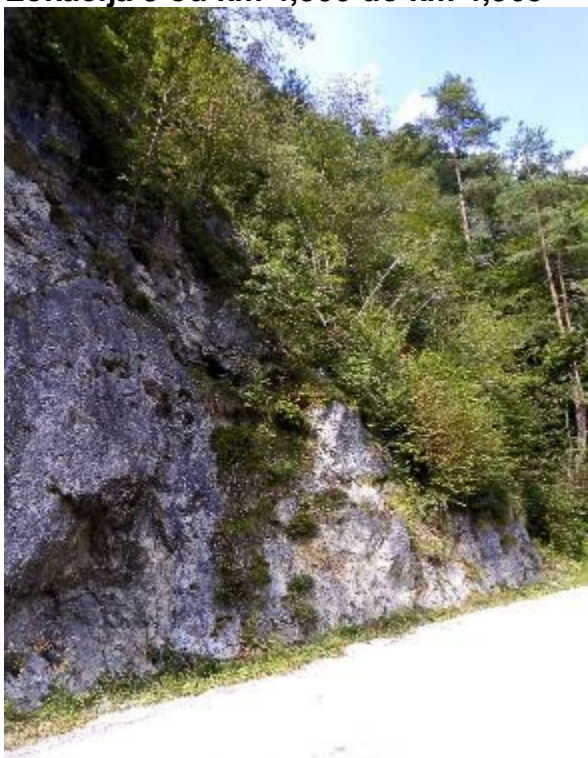
Lokacija 9 od km 4,500 do km 4,565
