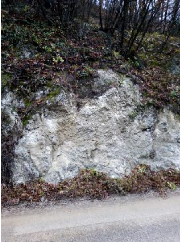
Lokacija 1 od km 2,286 do km 2,318
