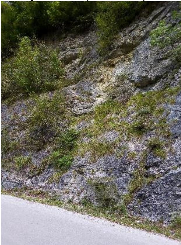
Lokacija 6 od km 3,530 do km 3,552
