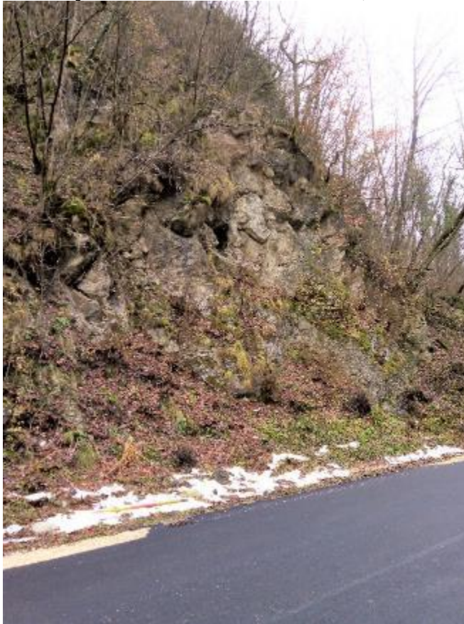
Lokacija 11 od km 4,867 do km 4,891
