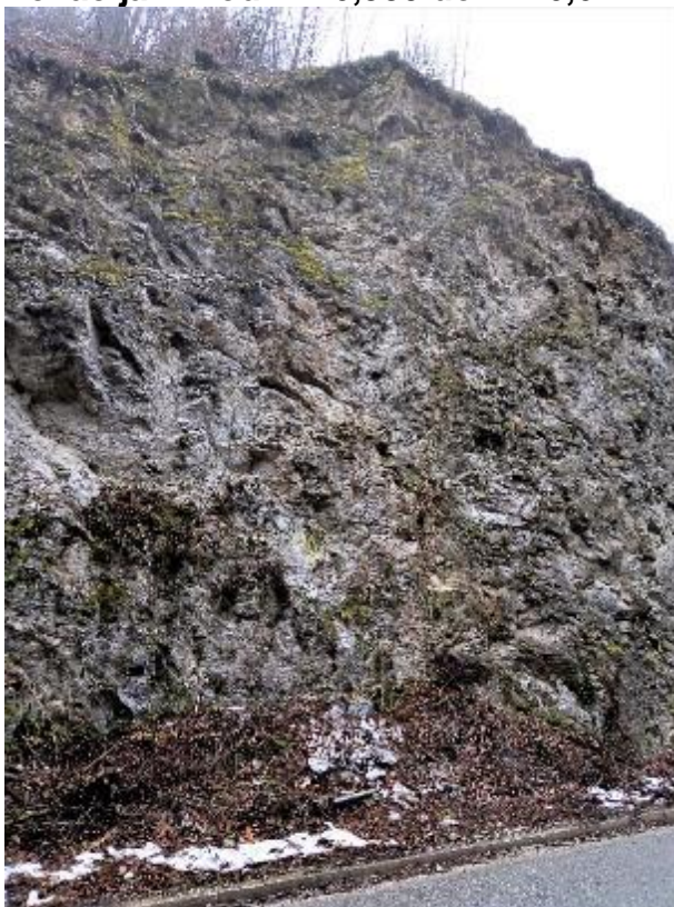
Lokacija 12 od km 6,380 do km 6,647
